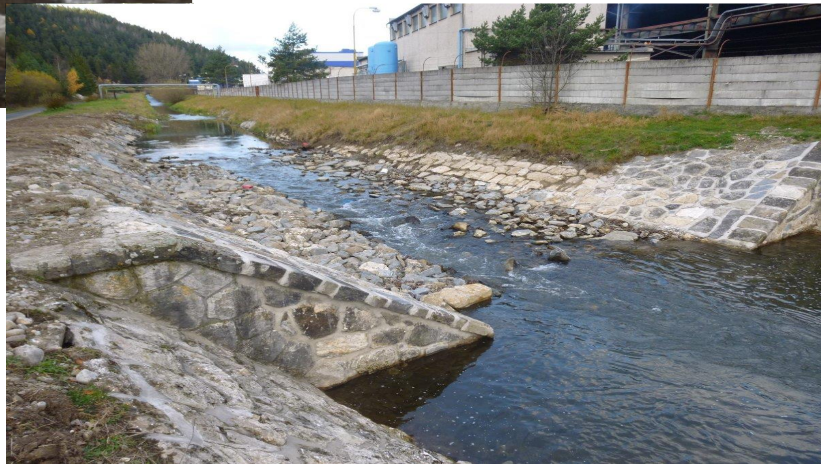
Mlynický potok pri Svite – odbúranie časti stupňa a doplnenie preliačeného sklzu
